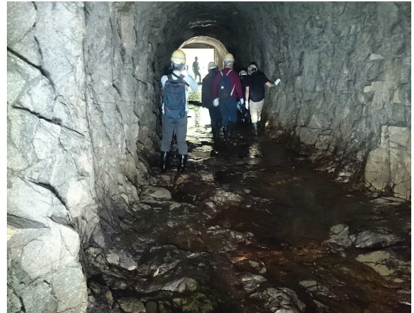
100年以上前に完成した布引五本松ダムの素掘りのバイパストネル（プラタモリでも取り上げられた）
