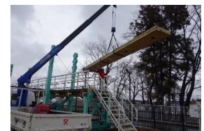
図3 FRP床版の撤去
