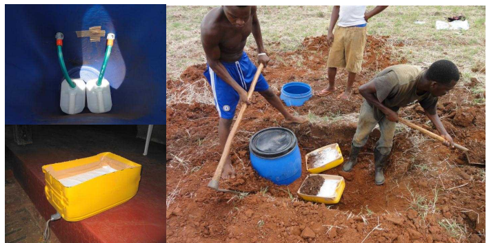
写真2. ライシメータ埋設の様子
