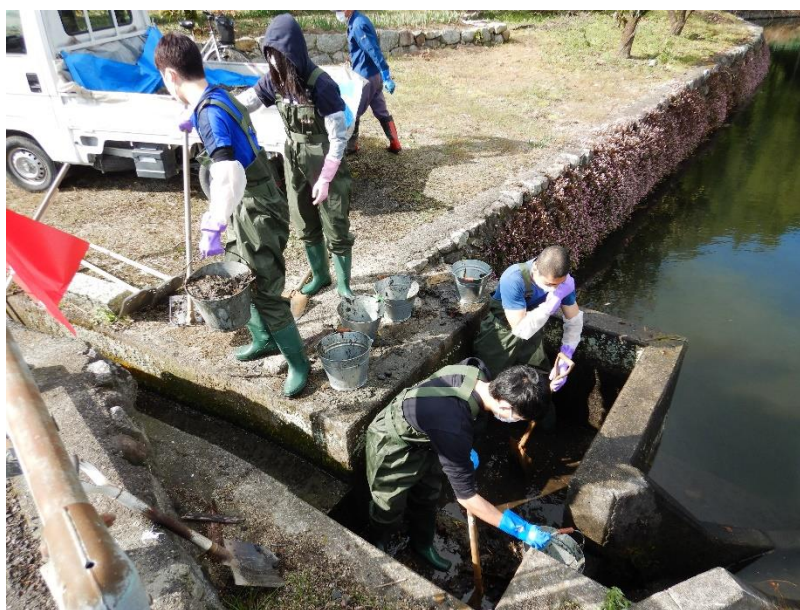
図4 対象の沈砂池における土砂除去作業
