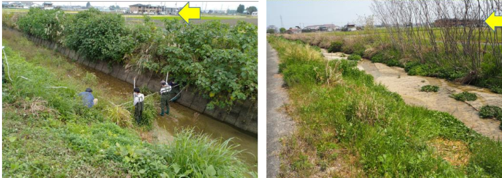
図2 同一地点における堆砂状況の比較。黄色矢印が同一の建物を示している。 左図) 本年の測量作業時の状況、右図) 2019 年 4 月時点の状況。
